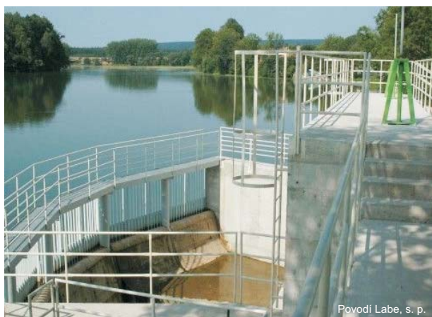
Abb. 3.1-4: Stausee Hvězda – fertig gestellte Hochwasserentlastungsanlage
