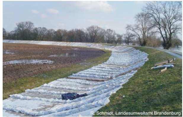
Abb. 3.2-10: Aprilhochwasser 2006, Rühstädter Bogen – landseitiger Sandsackverbau
