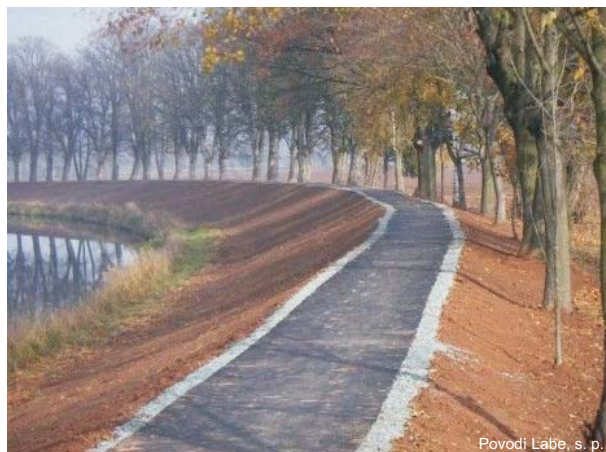
Abb. 3.1-5: Elbedeich auf dem linken Ufer in Hradec Králové
