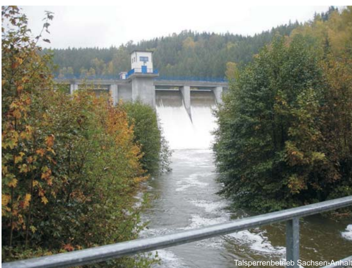
Abb. 2.6-6: Talsperre Wippra am 29.09.2007
