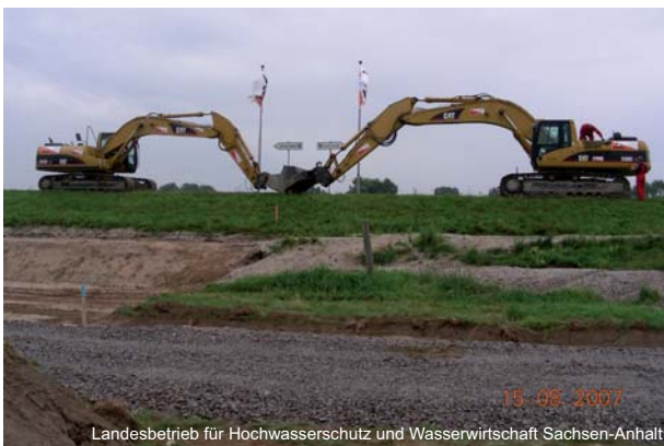
Abb. 3.2-6: Spatenstich Deichbaumaßnahme Prettin der Länder Sachsen und Sachsen-Anhalt am 15.08.2007
