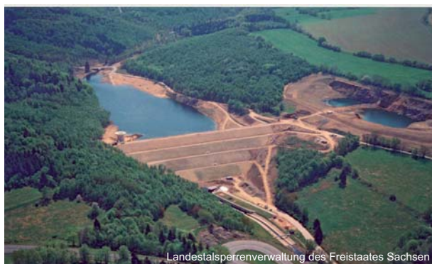
Abb. 2.1-6: Hochwasserrückhaltebecken Lauenstein an der Müglitz
