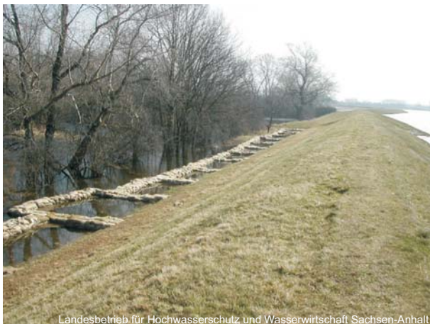
Abb. 4.3-6: Deichsicherung durch Sandsackverbau am Deich Prettin beim Hochwasser 2006
