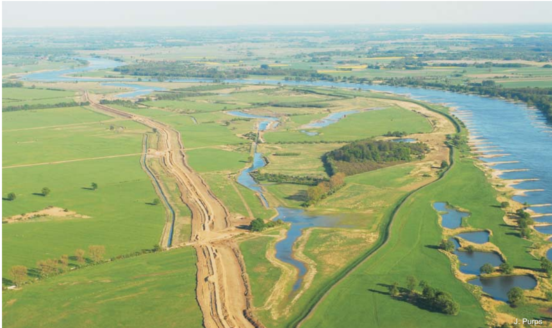
Abb. 2.5-14: Luftaufnahme Deichrückverlegung Lenzen
