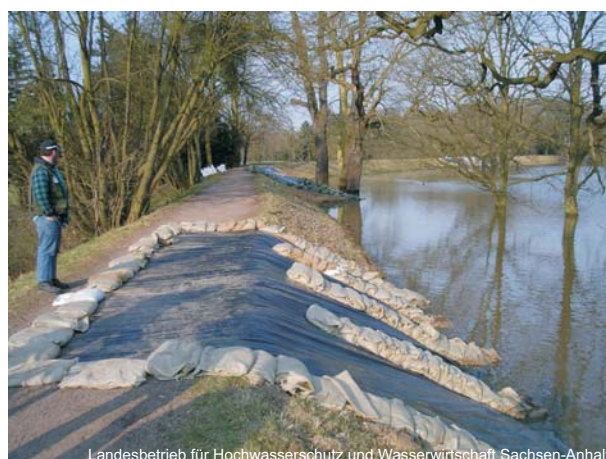
Abb. 4.3-5: Verteidigung Deich Wörlitz beim Hochwasser 2006 (Dessau-Wörlitzer Gartenreich, Welterbe der UNESCO)
